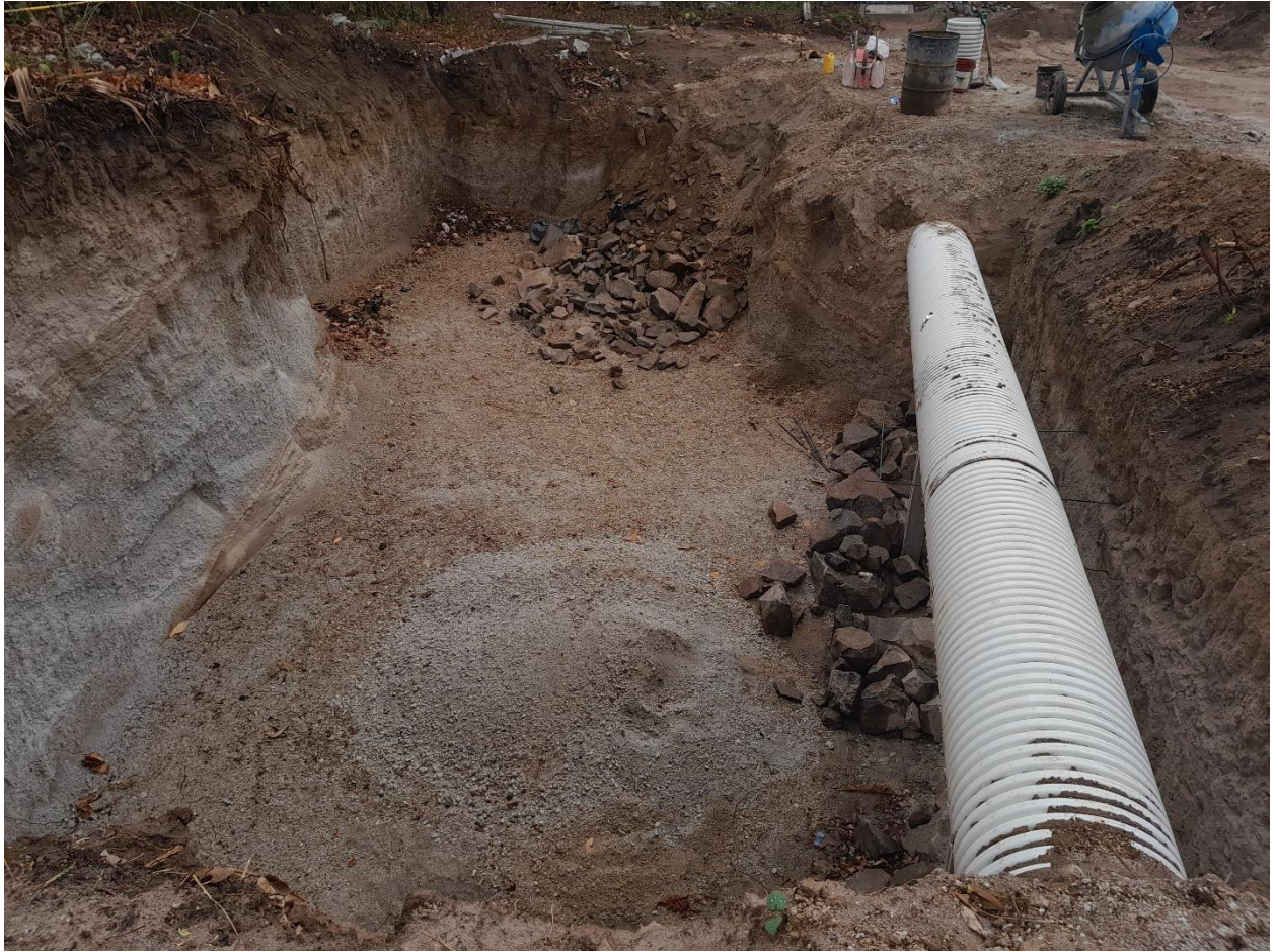
Figura 2 Sistema de detención e infiltración 1
