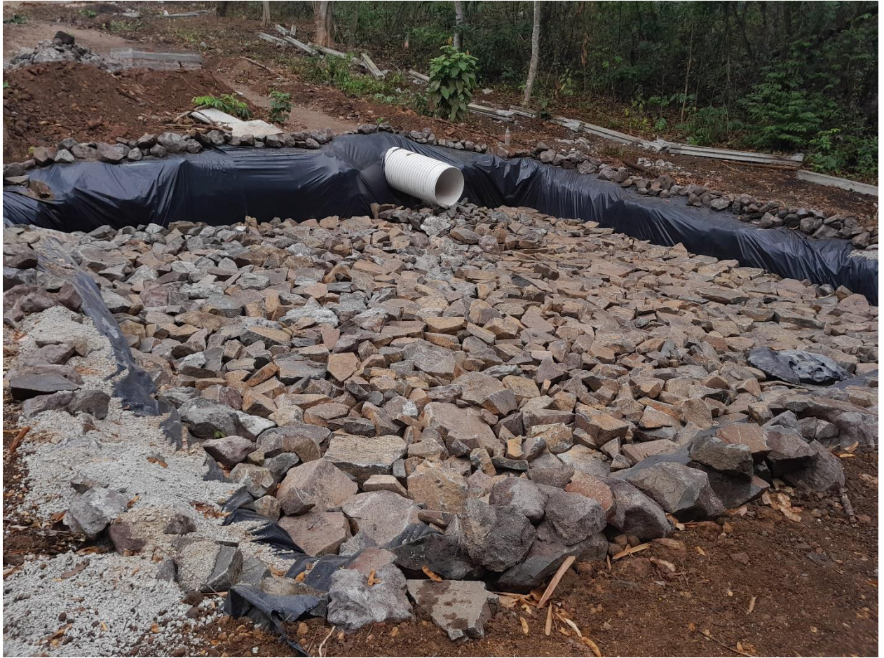
Figura 4 Sistema de detención e infiltración 2
