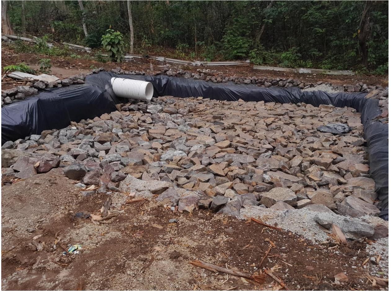
Figura 3 Sistema de detención e infiltración 2
